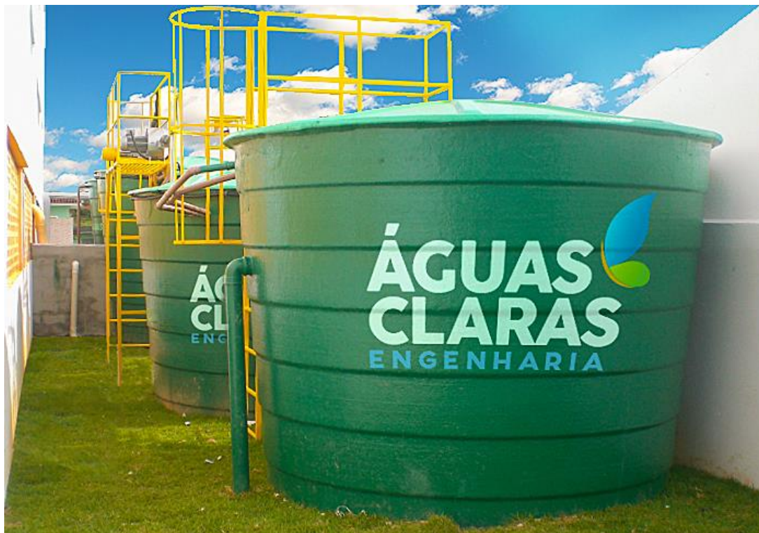
ESTAÇÃO BIOLÓGICA COMPACTA – EMPRESA MITSUBISHI, em GUAÍBA/RS - Vazão 22 m³/DIA
